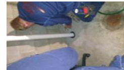
③ 파놓은 곳에 배출관 설치 및 주위를 실리콘으로 실링
