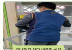
미세먼지 차단 방충망 설치
